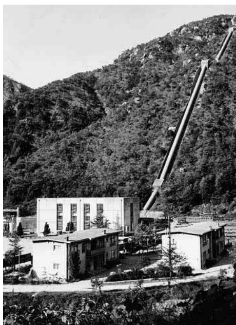
200m以上の高さにある渡ノ瀬ダムの水を落下させ発電する。手前の建物は発電所の社宅。（昭和30年代）
