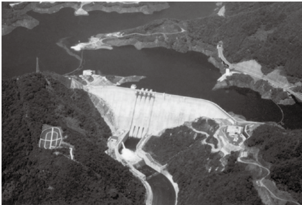
【弥栄ダム】大竹市小方町・岩国市美和町の境にあり、平成3年3月に完成。堤高120mの重力式コンクリートダムで総貯水容量が1億1,200万㎡となっている。目的は、洪水調節や上水道供給、工業用水道供給、水力発電など。
