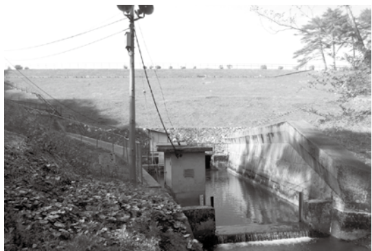
【飯ノ山ダム】廿日市市飯山にあり、昭和7年9月に完成。堤高18.5mの土えん堤式ダム(中に鉄筋コンクリートの心壁がある)で、総貯水容量が179万㎡となっている。目的は、水力発電。
