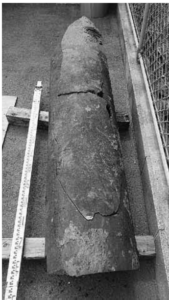
破損した配水管
