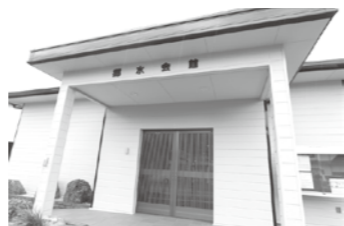
第2次避難場所(郷水会館)大竹会館南側
