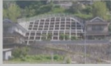
急傾斜地崩壊防止施設(がけ崩れ対策)
