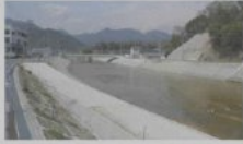
河川改修(河道拡幅)
