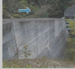
発災前の砂防堰堤
