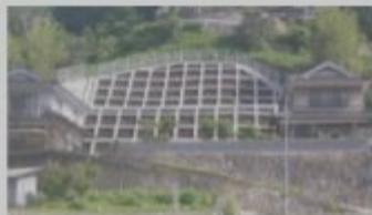
急傾斜地崩壊防止施設(かけ崩れ対策)
