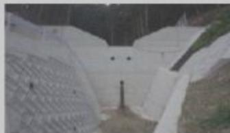
砂防堰堤(土石流対策)
