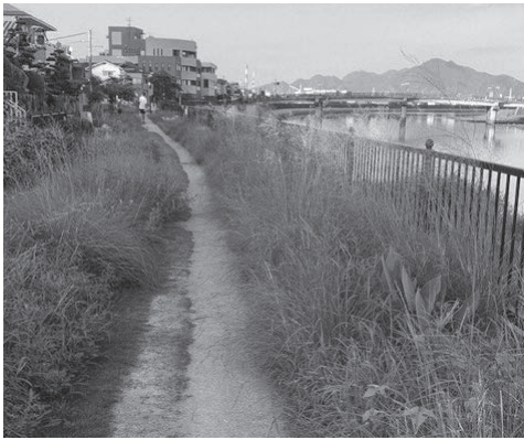
遊歩道の現状
