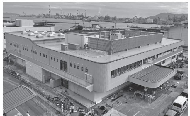
建設中の（仮称）おがたこども園
