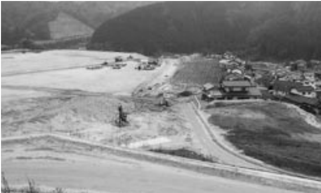
大願寺地区の造成地
