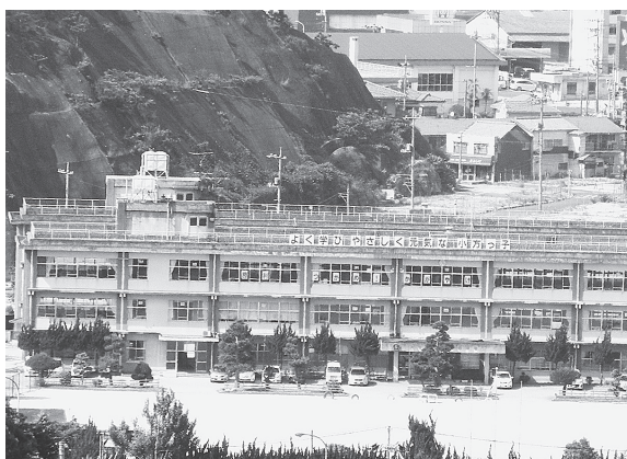
平成25年4月で移転する小方小学校
