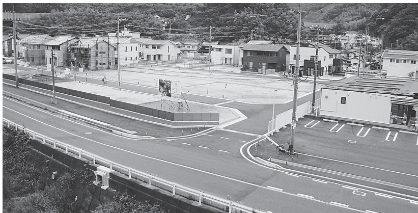
新設された御園6号線・7号線
