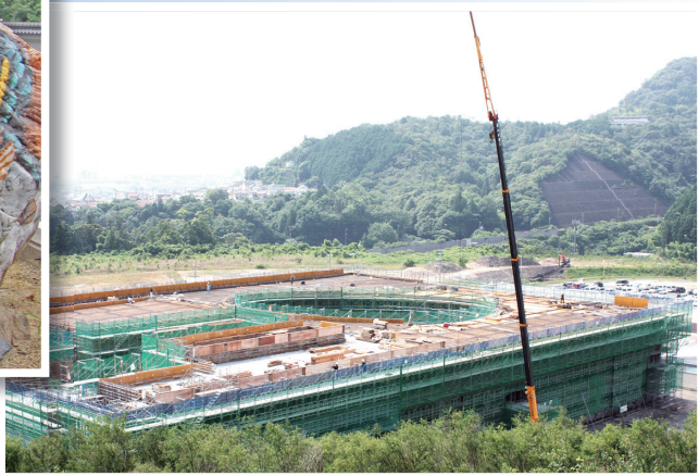
小方小・中学校建設中(H24.7.12 現在)
