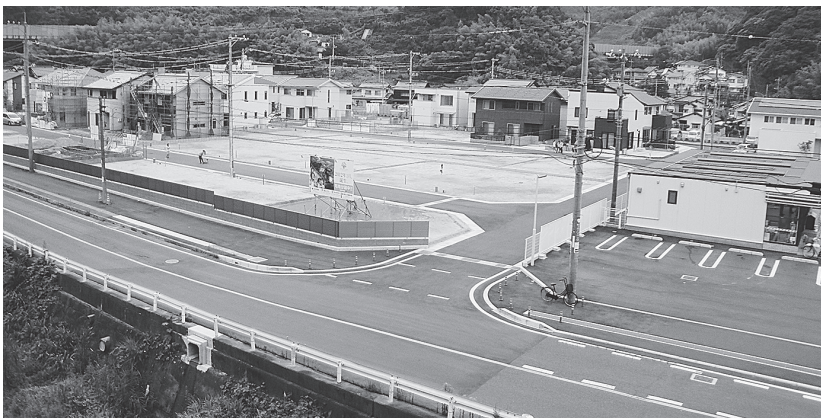
新設された御園6号線・7号線
