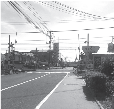
改良予定の青木踏切
