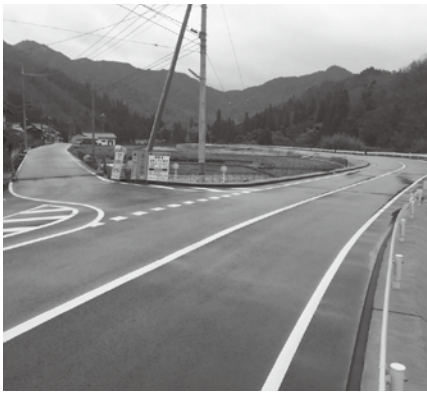
県道栗谷大野線(谷尻バイパス)
