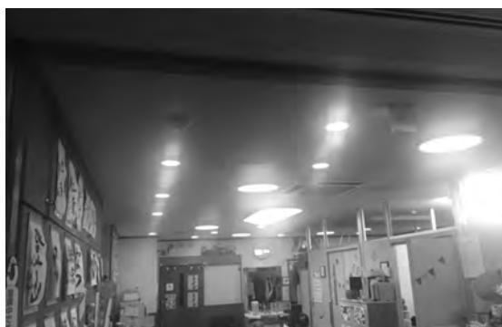
スプリンクラー設置予定場所 「小規模多機能型居宅介護みりのり」
