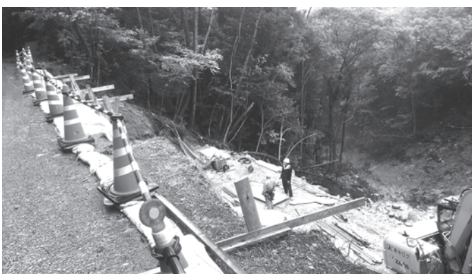
補修工事の様子
