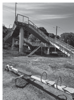
現在の城山陸橋
