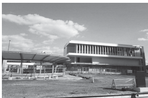
大竹駅整備工事中の西口交流広場
