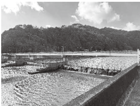
中市堰歩道橋
