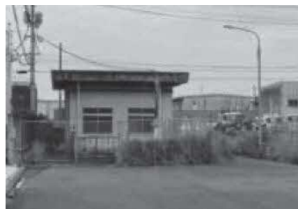
港町排水ポンプ場
