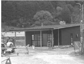
建設中の交流館
