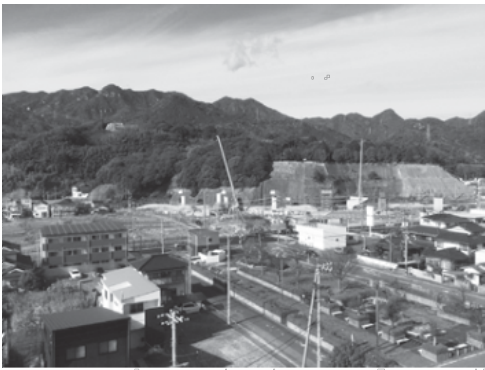
岩国・大竹道路の建設状況
