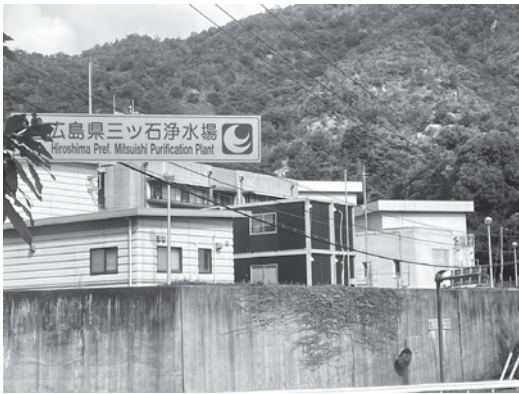
広島県三ツ石浄水場
