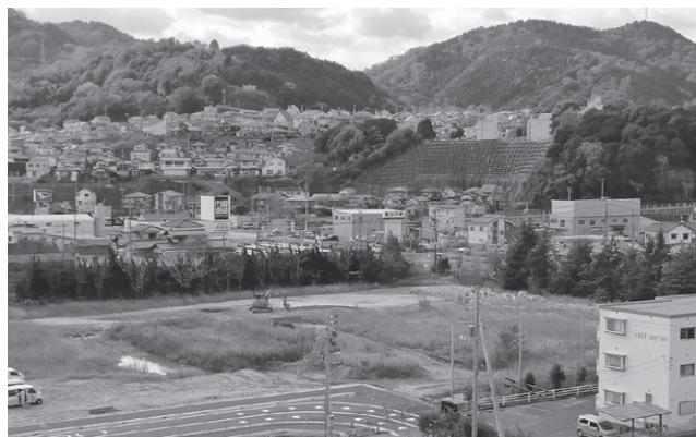
旧小方中学校跡地
