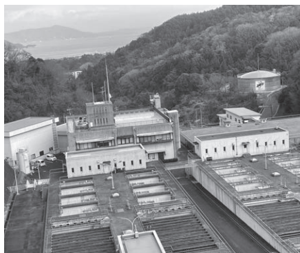
広島県三ツ石浄水場の全景 (大竹市の三ツ石調整池も見える)
