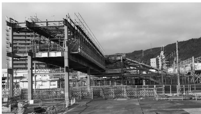
令和3年12月大竹駅東口工事の様子
