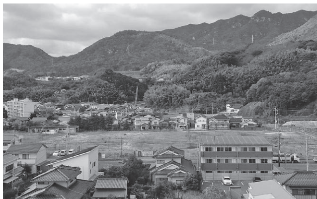
旧小方小学校跡地
