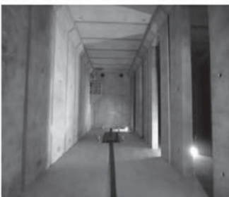
市街地に降った雨を一時的に貯留することにより、河川への流出を抑制し、内水浸水被害の防止・軽減を図る
