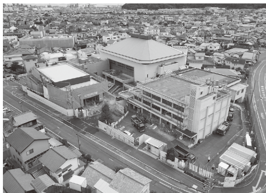
完成間近の大竹会館新築棟本館
