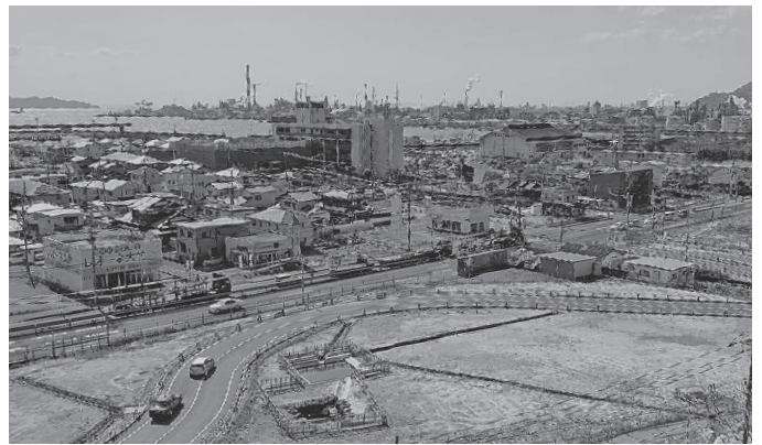
市役所前の岩国大竹道路建設現場
