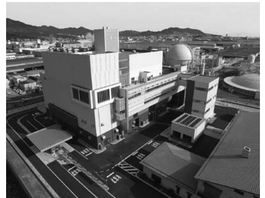
はつかいちエネルギーセンター
