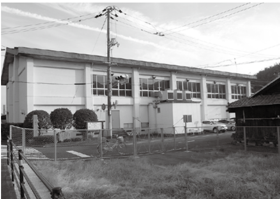
解体される小方公民館の体育館部分
