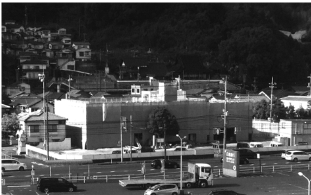
改修中の旧小方公民館
