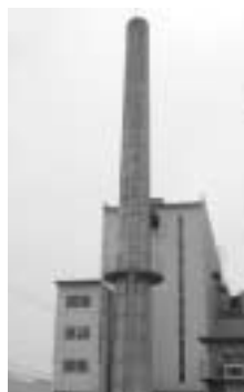
取り壊しをする 旧ごみ焼却炉煙突
