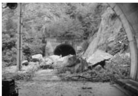
斜面の崩落により通行止めとなった弥栄3号と4号トンネル間
