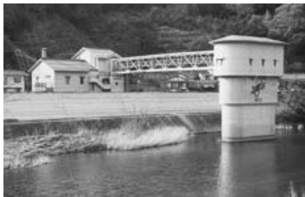
第二期工業用水の取水塔(防塵)
