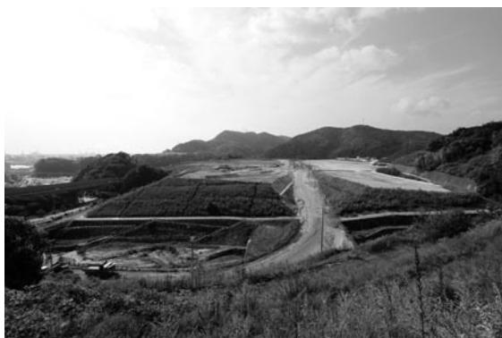
小方小・中学校建設予定地（平成23年10月撮影）
