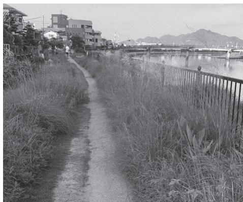
遊歩道の現状
