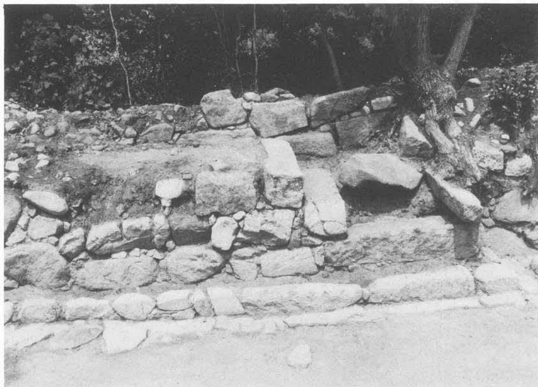
a. SX9 石階段近景（南東から）
