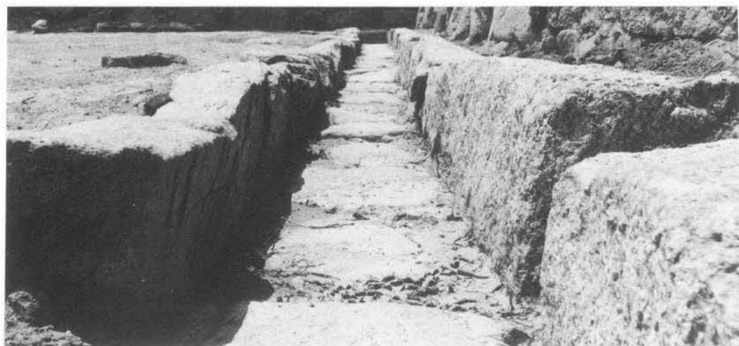
上・排水溝暗渠部 下・排水溝北東部
