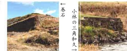
木野村(中津原)の小林というところに、洪水から村を守るため、大きな石を“三角”に積み重ね水の流れを反らせた三角和久と、それに続く「巻石」と呼ばれる堤防が築かれています。城郭のごとく強固に作り上げられた石垣は、江戸時代初頭の福島堤防とも言われています。
