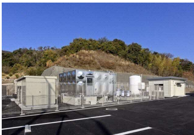
貯水槽・備蓄倉庫
