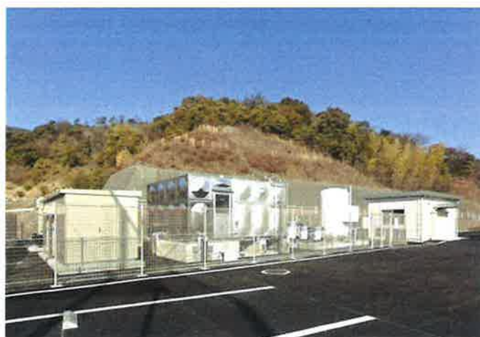
貯水槽・備蓄倉庫
