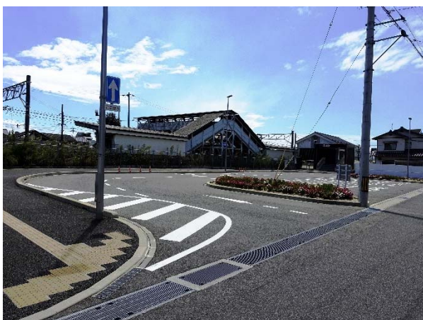
JR 玖波駅西口広場
