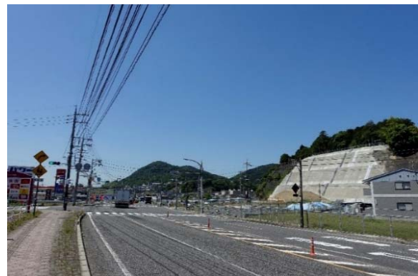
岩国大竹道路整備状況
