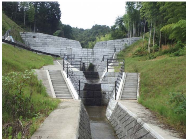
小方1号砂防堰堤
