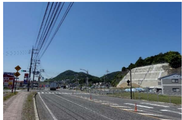
岩国大竹道路整備状況
