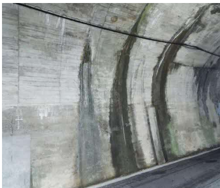
覆工・坑門の漏水
