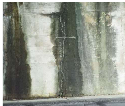
覆工・坑門のひび割れ
