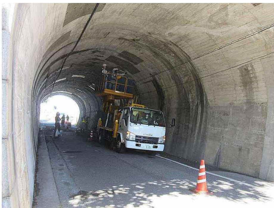
写真 1-2 トンネル定期点検状況（令和 7 年度）
