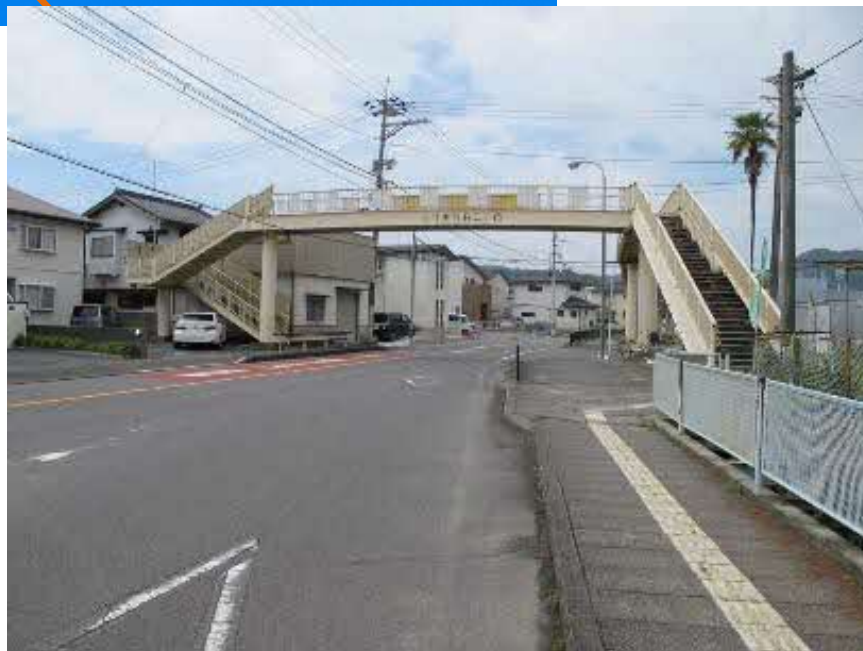
学園歩道橋（鋼橋） L=34.0m 1973年架設
