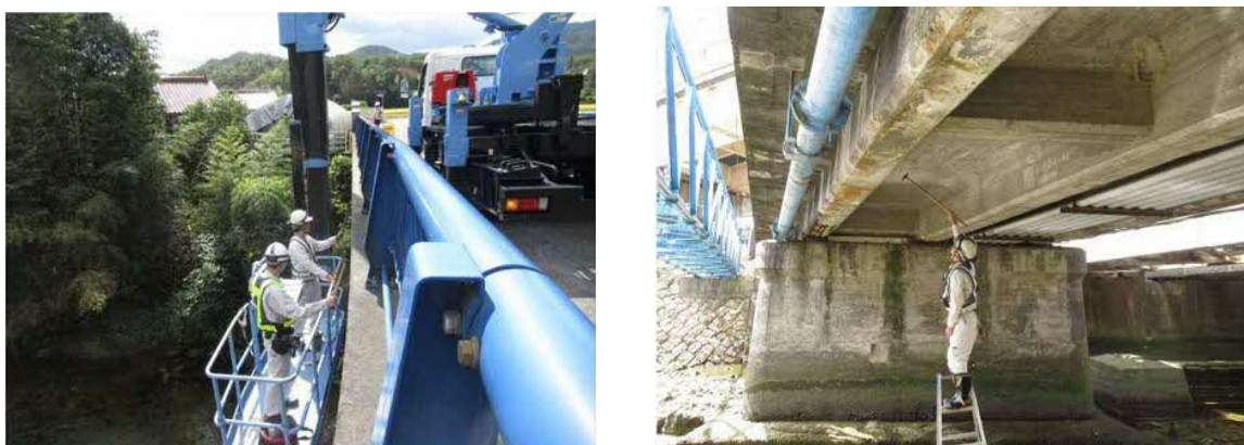
橋梁定期点検状況
