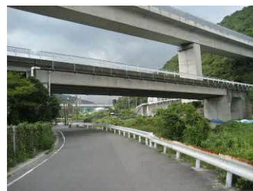
神田橋 (PC橋) L=40.1m 1990年架設
