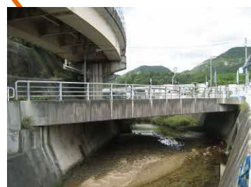
小方橋 (PC橋) L=24.8m 1982年架設
