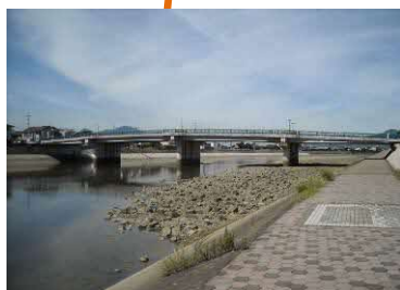
大和橋 (PC橋) L=107.6m 1997年架設
