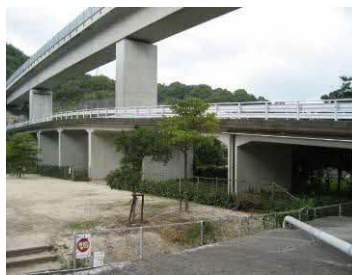
玖波9号線1号橋 (RC橋) L=66.1m 1985年架設
