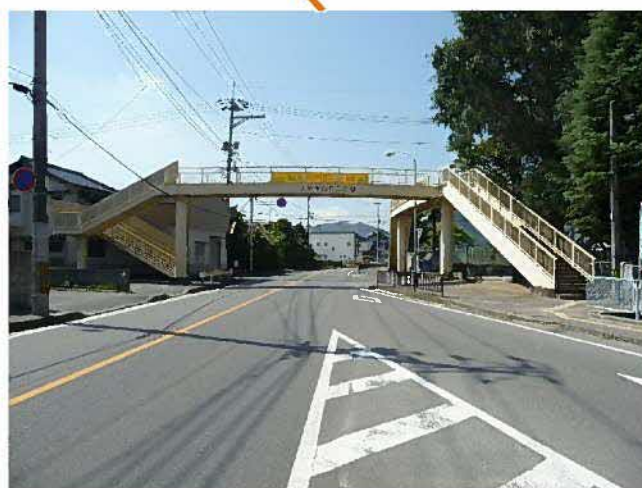
学園歩道橋 (鋼橋) L=34.0m 1973年架設
