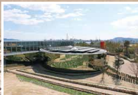
ミラーガラスに覆われた楕円形のエントランス棟。周囲の景色を映すことで、建物の存在感を感じさせないように設計されている。
